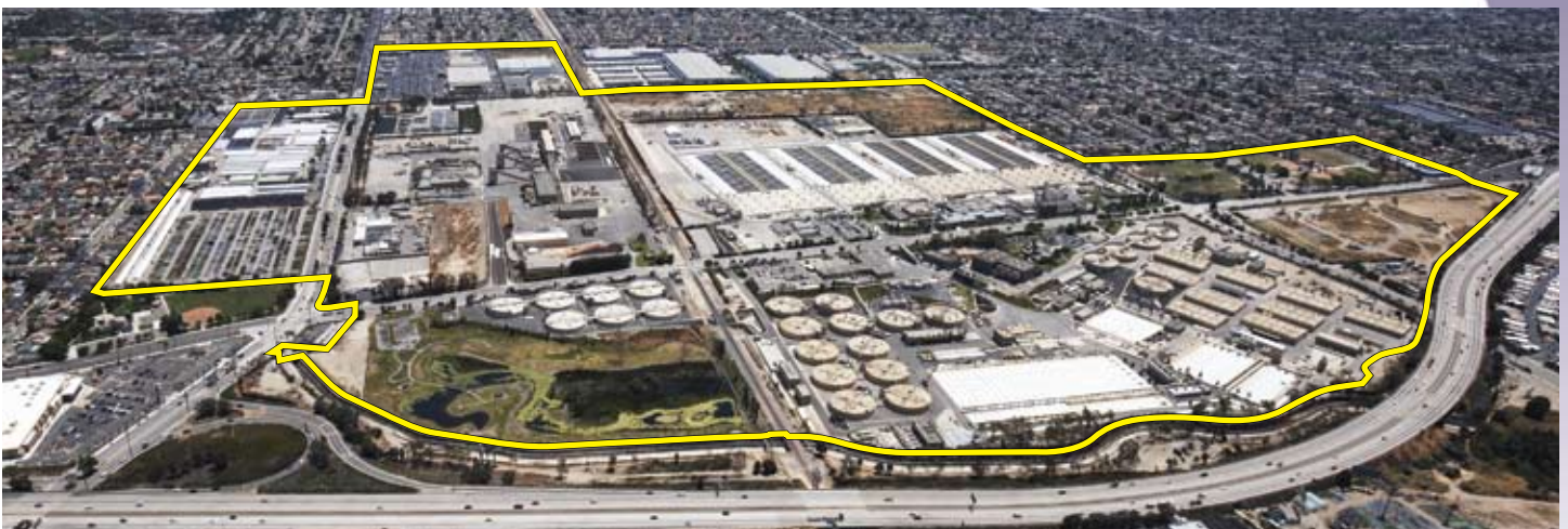
La Planta Conjunta de Control de la Polución del Agua, en Carson. Límites de la propiedad resaltados en amarillo.
